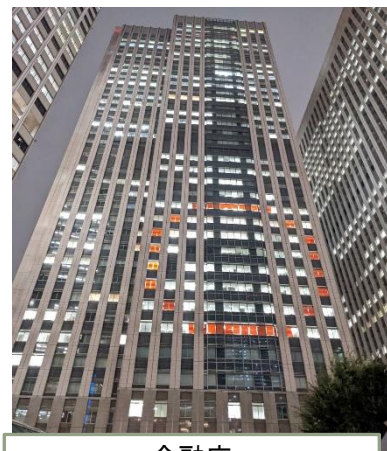
金融庁 (中央合同庁舎7号館)
