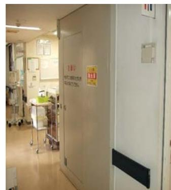
写真 11 防火設備(旧乙種防火戸)
