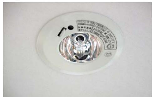
非常用の照明装置は、停電により内蔵のバッテリーが作動する仕組みとなってい
