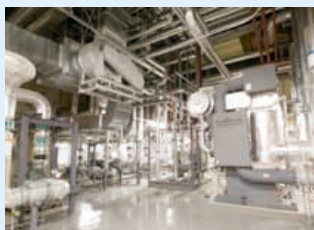
■ 蒸気二重効用吸収冷凍機
