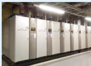
■ 高効率小型貫流蒸気ボイラー
