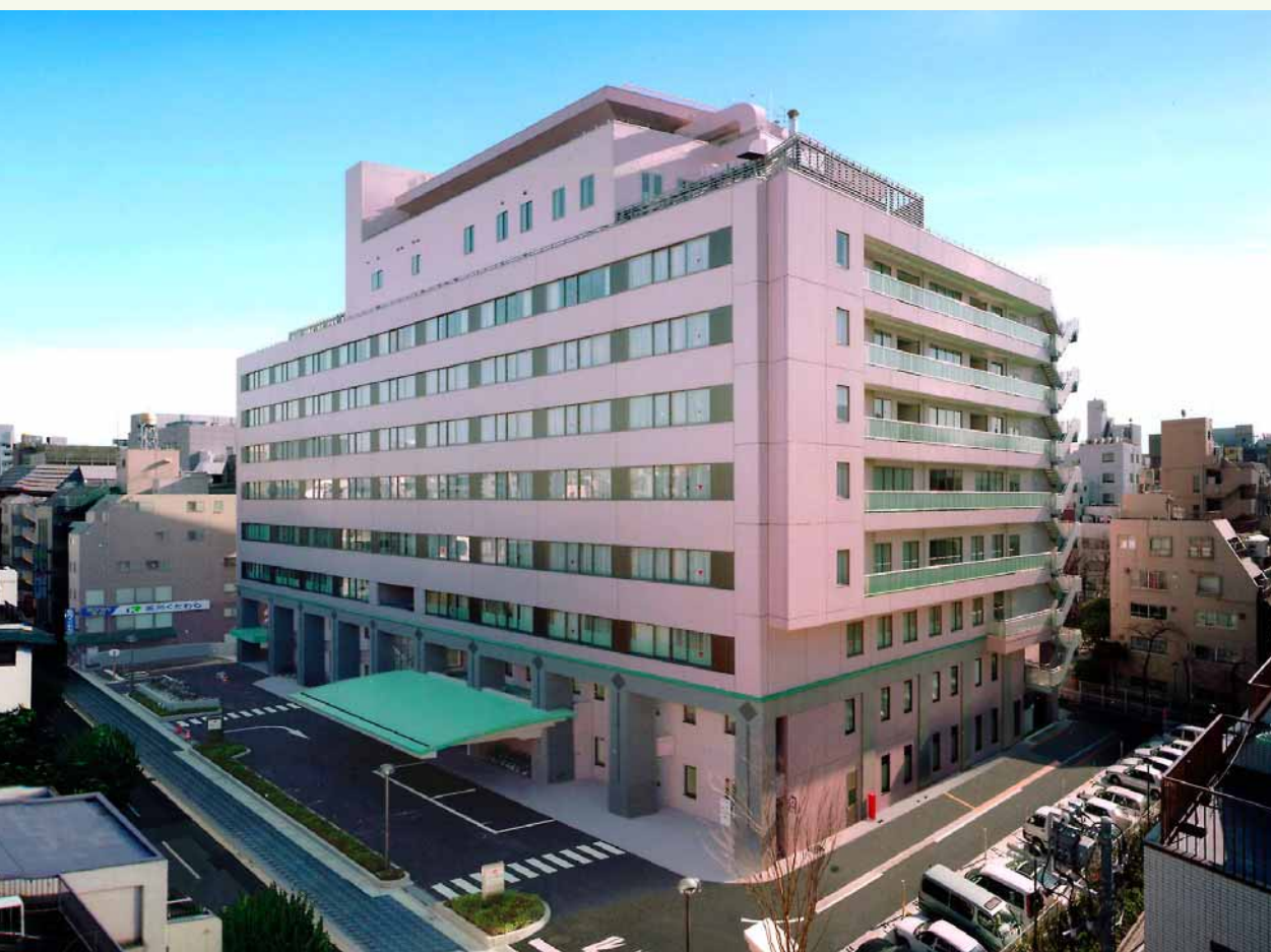
■病院の全景（北西面）
